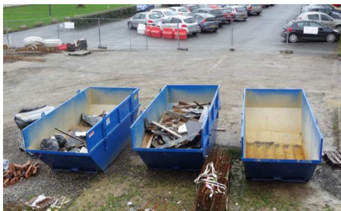
Aire de stockage des bennes
