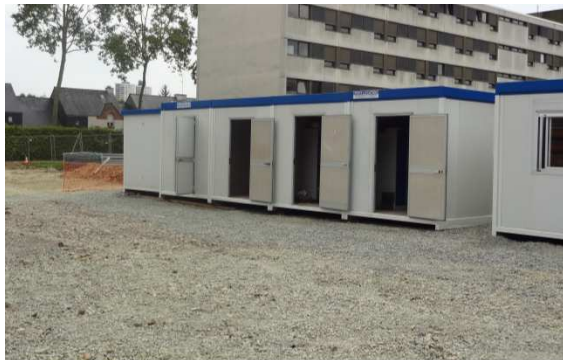
Empierrement au niveau de la base vie
