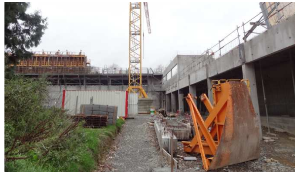
Cheminement piéton empierré
