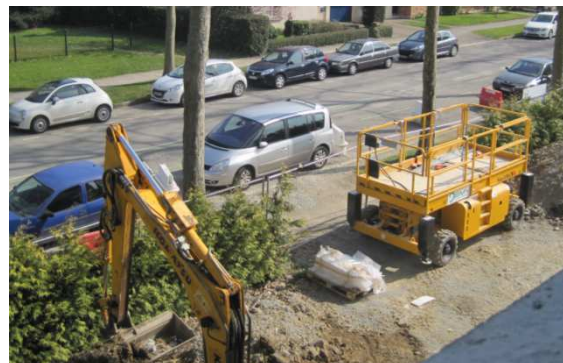
Clôture du chantier
