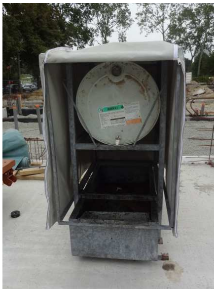
Armoire sur rétention pour huile de décoffrage
