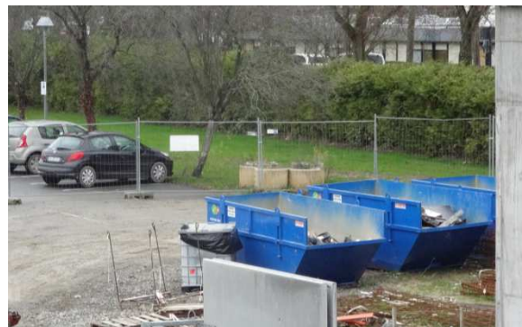
Clôture du chantier
